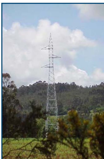
Apoyo de celosía
