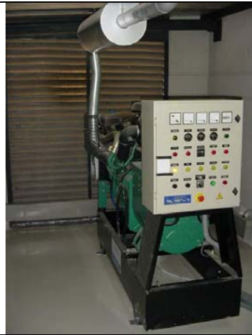
Grupo electrógeno para alimentación de emergencia en c.a.
